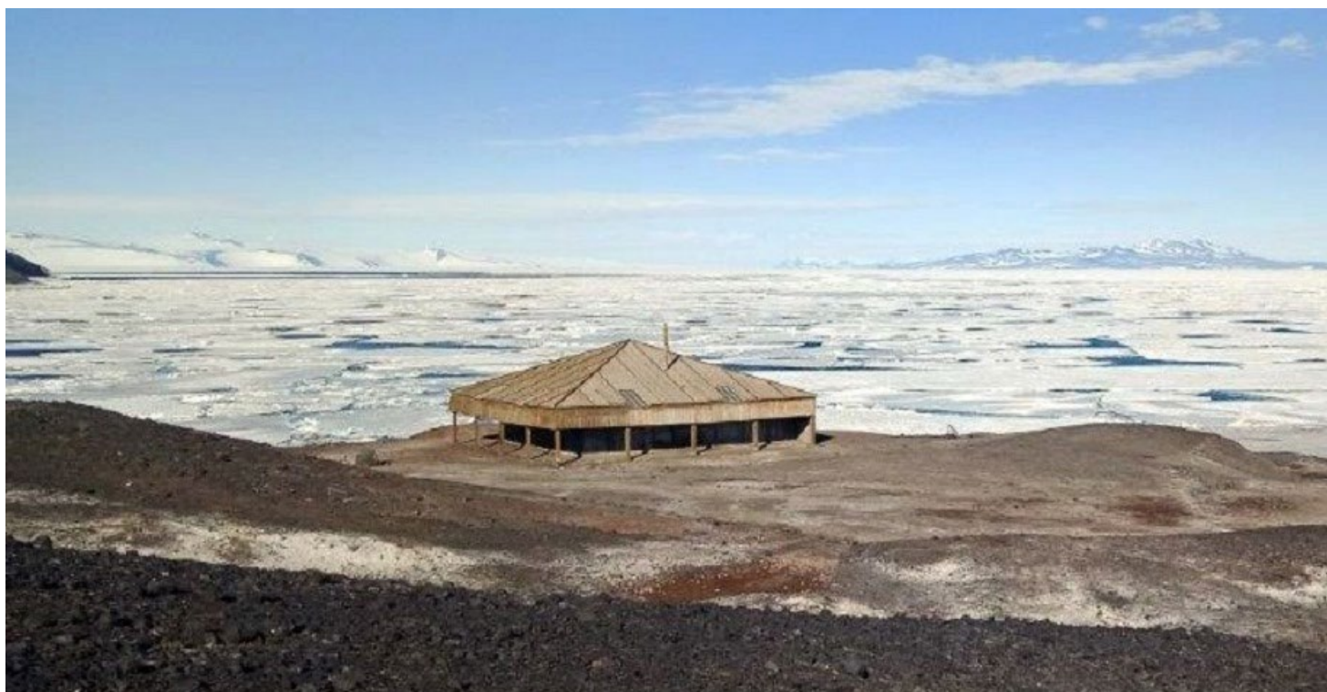
Рис. 1: Хижина «Дискавери», построенная экспедицией Скотта (ООРА № 158 и ИМП № 18) в районе Хат-Пойнт, вид в направлении на юг в сторону острова Уайт и острова Блэк. Фото: S. Vamford, Antarctica NZ, Jan 2020.
