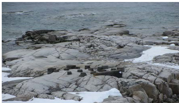
Fondations de la cabane
