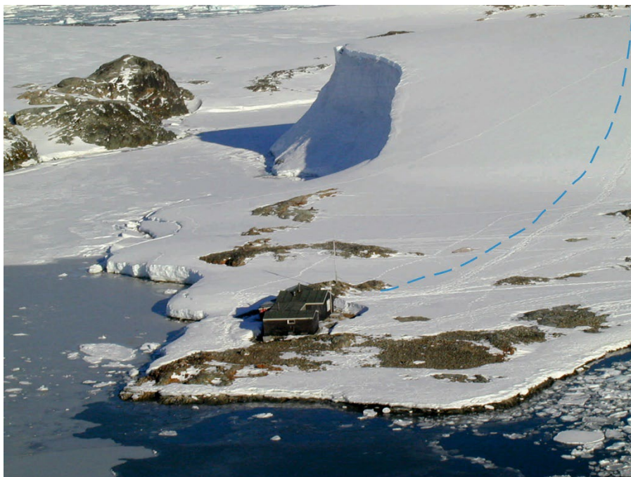
La cabane vue de l'est montrant sa proximité à la mer (chemin recommandé pour les visiteurs vers le haut de la calotte glaciaire en arrière-plan)
