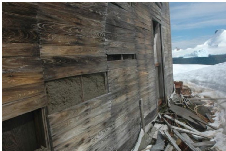
Vue latérale du dortoir de la base Est
